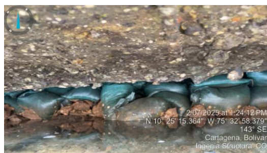
Imagen 7. Parte inferior estabilizada con bolsacretos, foto 2
