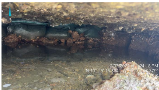
Imagen 6. Parte inferior estabilizada con bolsacretos, foto 1
