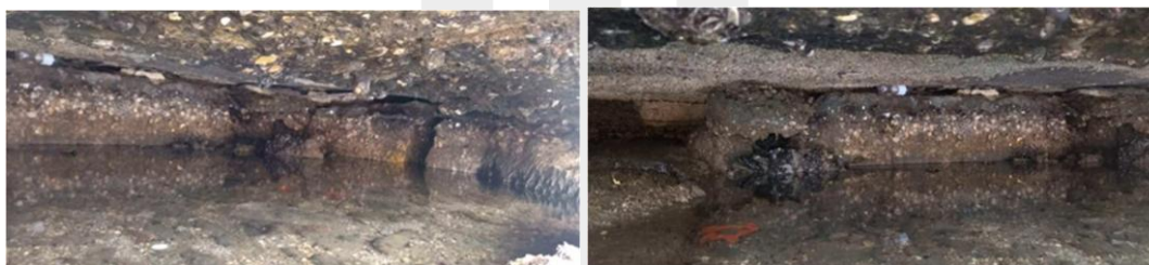
Imagen 8. Socavación mostrada en el sector 3 previo a las intervenciones de la empresa BUZCA
