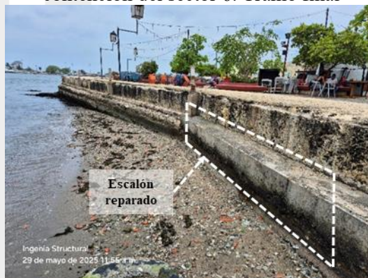
Imagen 22. Vista general del sistema de contención sector 6 con reparaciones en mortero. Zona restaurante
